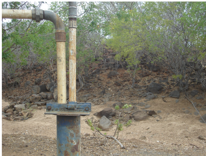
Foto1. Poço perfurado no encontro de dique máfico (cinza escuro ao fundo) com drenagem, encaixado em gnaisses na localidade de Mucunguelo, Uauá, Bahia.
