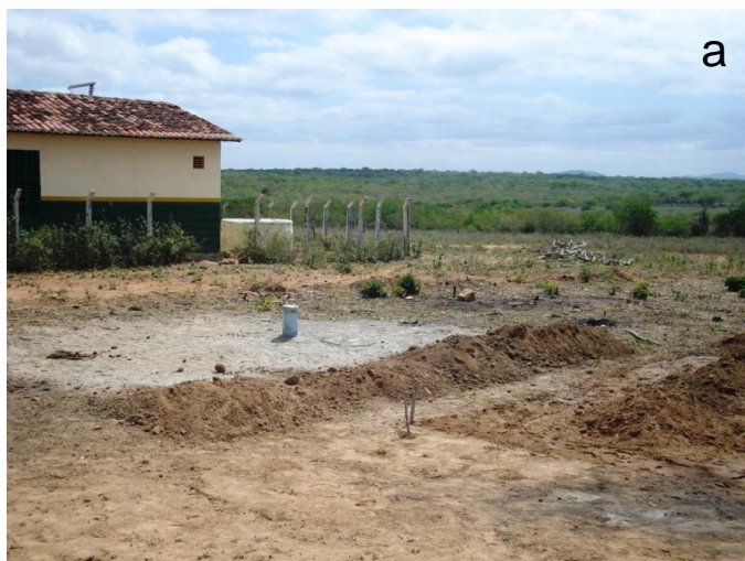
a) Poço seco, perfurado por terceiros, locado em zona de platô em gnaiss/migmatito, na localidade de Beldroega, Uauá; b) Poço locado em alto topográfico (divisor de água) sobre veio de quartzo, seco, em Lagoa do Serrote, Uauá.
