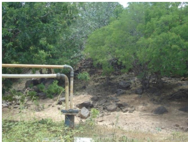
Poço Tubular; Prof. 72m; Vazão 16,16 m 3 /h; STD 2714 mg/l; Dique Máfico; Mucunguelo, Uauá
