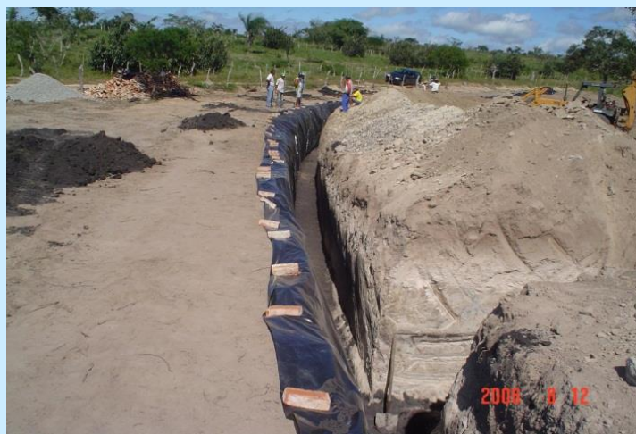
Barragem subterrânea, em construção
